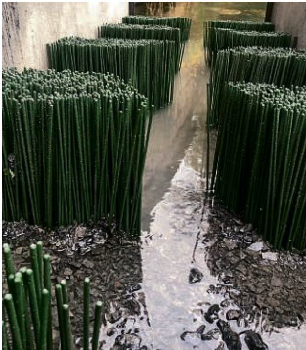
Umwelt- und fischverträglich: Die Anlage ist mit einer Fischtreppe, Aalabstieg und Feinrechen ausgestattet.
